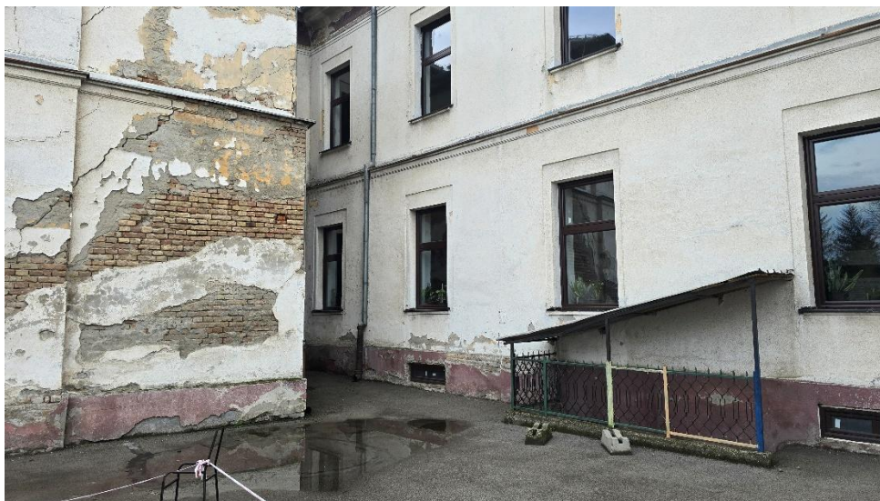
pukotine na spoljašnjem zidu usled značajnog sleganja objekta
