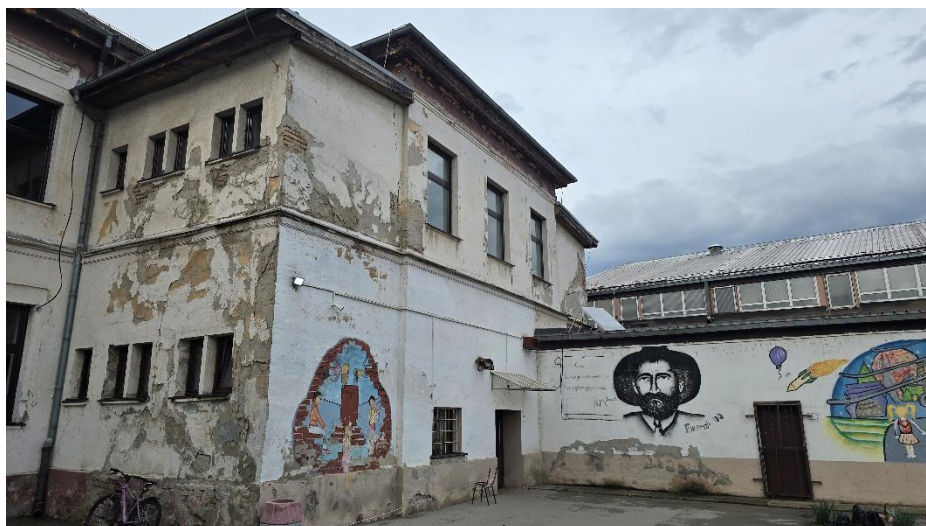
pukotine na spoljašnjem zidu usled značajnog sleganja objekta
